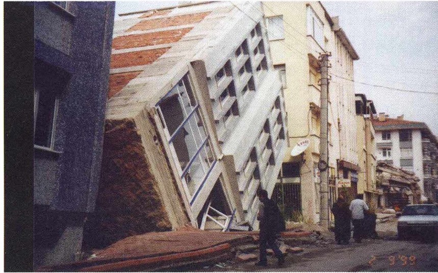
Adapazarı'nda sıvılaşma nedeniyle devrilmiş bir bina
