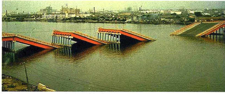
1964 Niigata depreminde (Japonya) sıvılaşma sonucu yana yatmış binalar ve yıkılan Showa Köprüsünden bir görünüm
